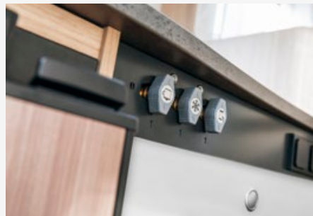
Mandos de gas centralizados
