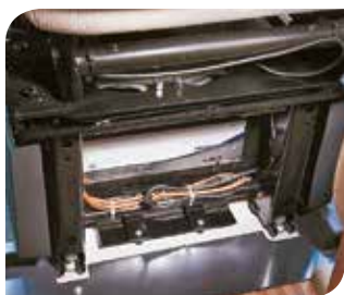
Baterías de GEL de altamente eficientes y sin mantenimientos.
